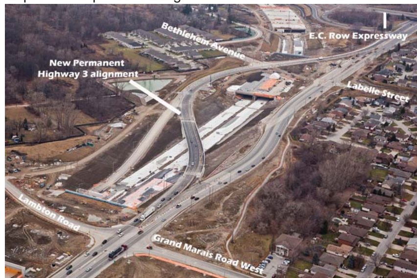
photo aérienne de l'autoroute 3 est
