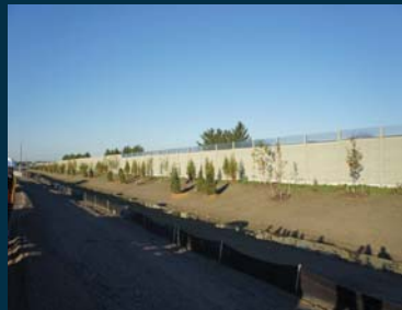
Les travaux en pente
