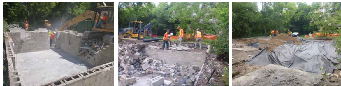
Étapes de la construction du gîte d'hibernation — Nettoyage du sous-sol, pose manuelle des blocs de béton, du géotextile et du sable sur le dessus.
